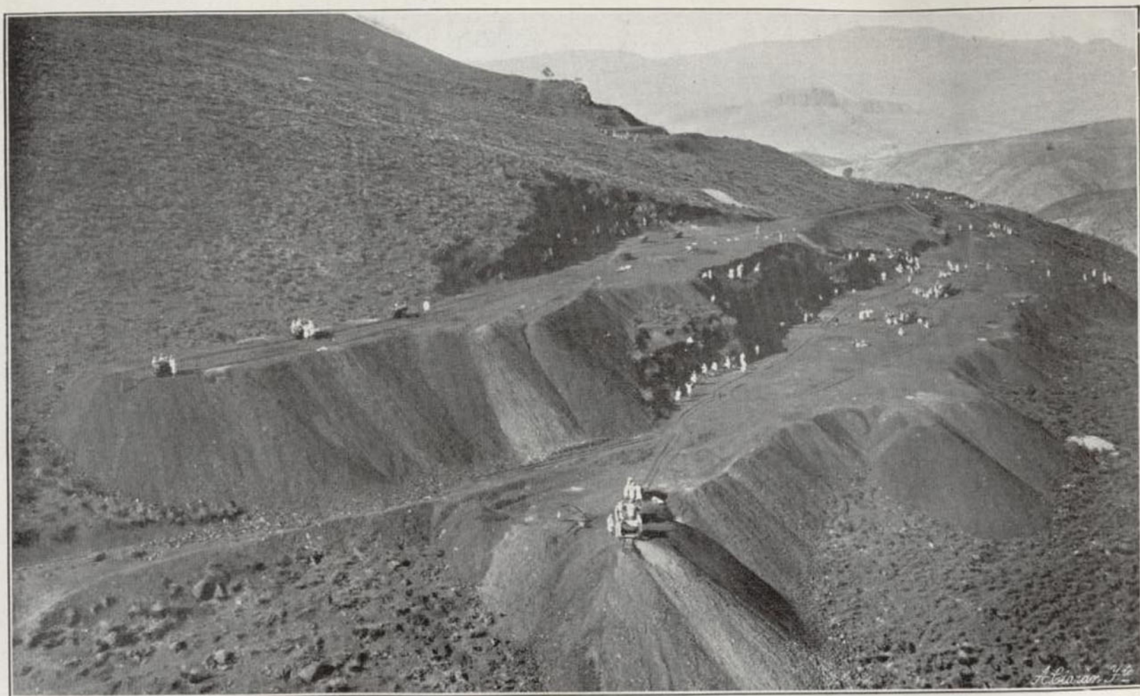
FOTOGRAFÍA 1. — Zona occidental: Monte Uixan. Explotación de las chirteras.
